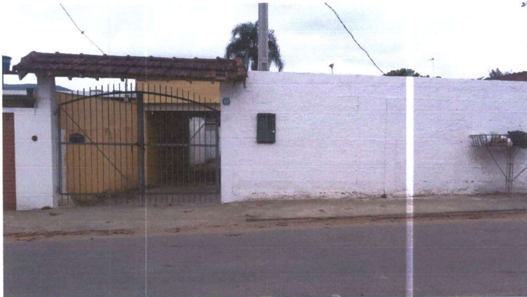
Foto 01 – Frente do imóvel
