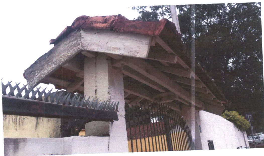
Foto 06 – Detalhe da cobertura do portão de entrada;
