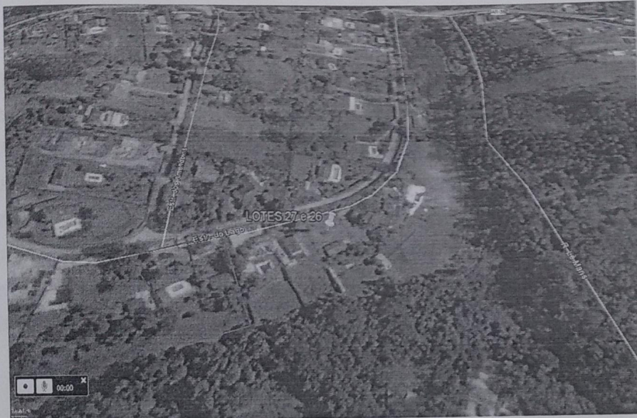
Figura 2: Vista aérea do avaliando e da região de entorno, Google Maps Os dois lotes são vizinhos e perfazem 4.950,00 m 2 .
